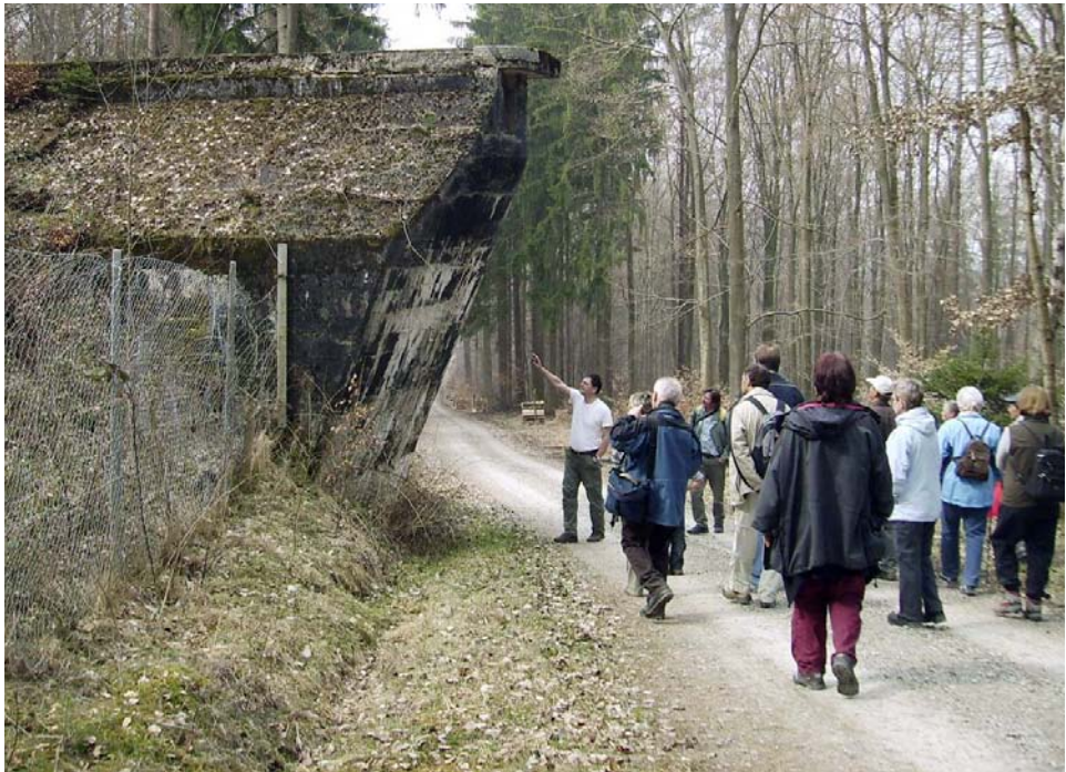
Ruine einer geplanten Autobahnbrücke mitten im Wald: das so genannte Bauwerk 105 am Roten Weg zwischen Burgsinn und Gräfendorf.
