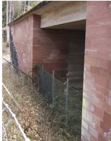
Mit Buntsandstein aus Bad Orb waren zahlreiche Brücken- und Entwässerungsbauwerke an der Strecke 46 verkleidet.
