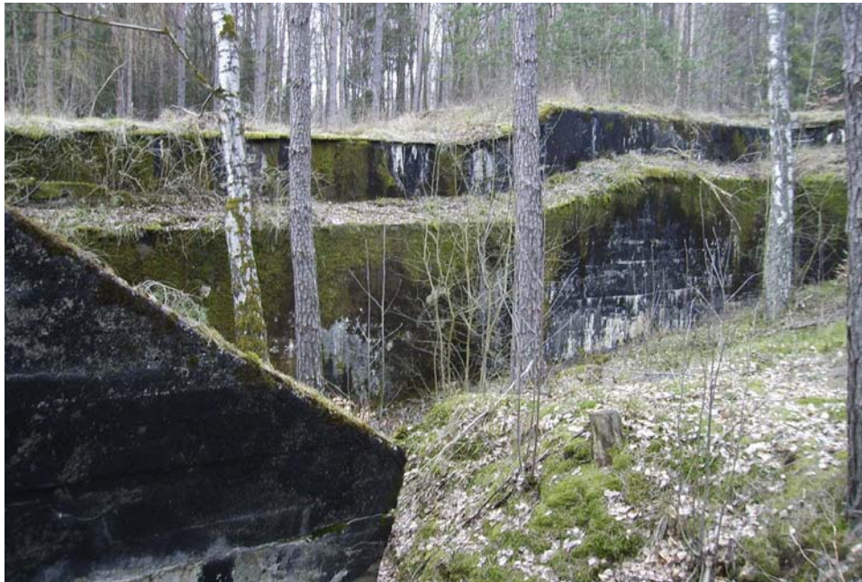
Blick ins Innere eines Brückenlagers: Deutlich zu erkennen ist die unterschiedliche Höhe der beiden Fahrbahnen. Fotos: Schimpfermann
